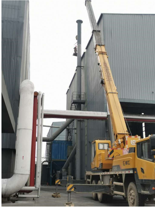
图 4.1-4 原料库装卸、混配除尘器和排气筒
