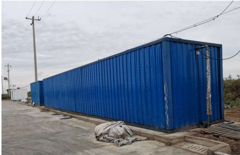
图 4.1-2 生活一体化污水处理装置
