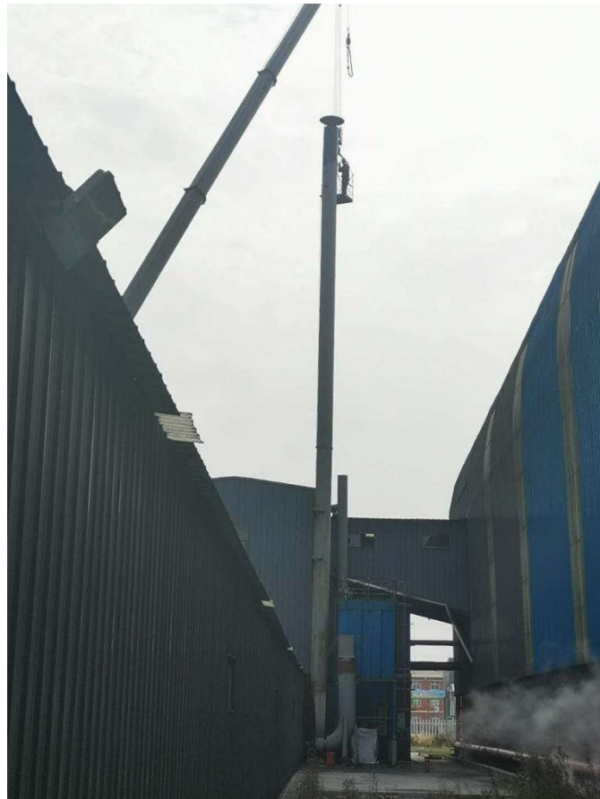
图 4.1-4 原料库装卸、混配除尘器和排气筒
